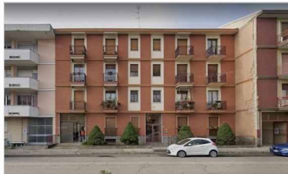
Figura 1 – Edificio oggetto di studio. Fonte: Google Maps.
